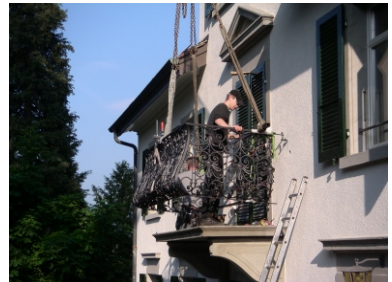
Sanierung Balkongeländer
