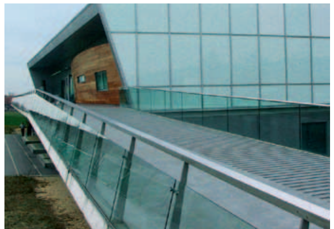
Gebäudezugang: Geländer aus Glas mit Chromstahl-Handlauf, Höhe 100 cm
