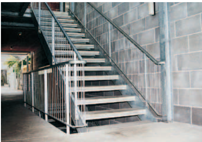
Offene Metalltreppe: Metall-Staketengeländer, Öffnungen bei den Treppenstufen und beim Geländer kleiner als \varnothing 12 cm
