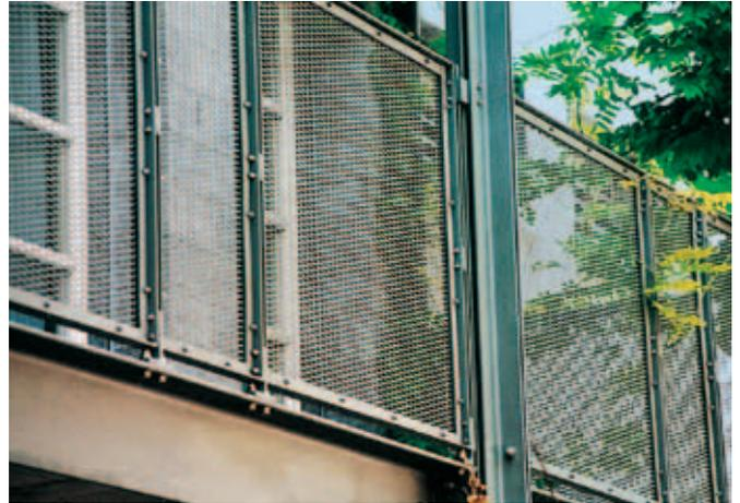
Balkongeländer mit einer Streckmetall-Füllung: in Metallfassung eingerahmt und an eine Primärkonstruktion montiert, keine Öffnung grösser als  $\varnothing$  12 cm
