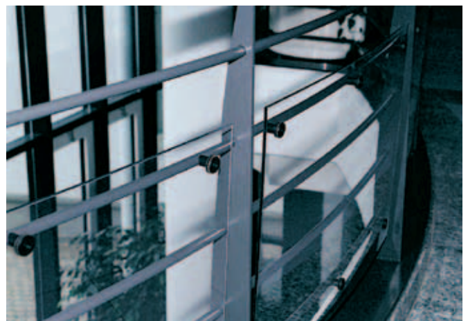
Sicherheitsglas auf der Innenseite, Höhe 75 cm: durch Schliessen der Öffnungen wird das Beklettern verhindert
