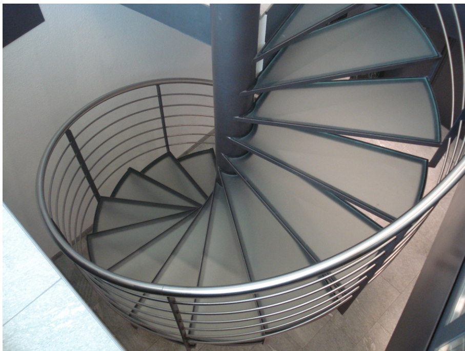
Spindeltreppe mit Glastritten
